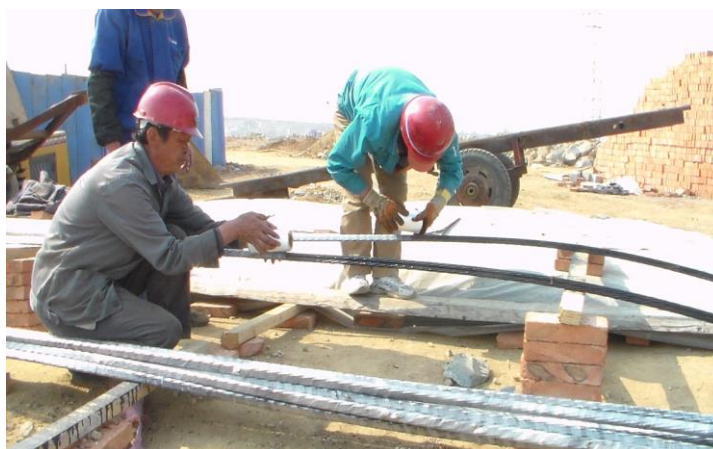
图 6-4 锚杆防腐施工
