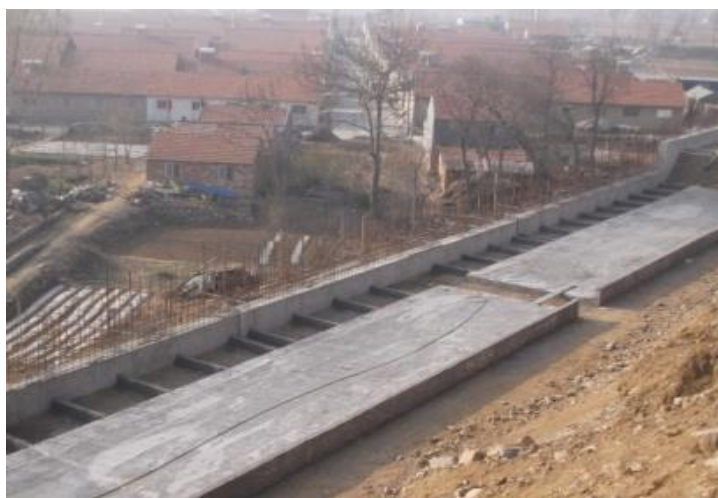
图 9-1 钢筋混凝土隔板
